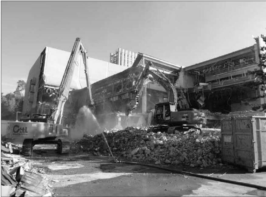
Abbruch einer Halbleiterfabrik in Böblingen mit Longfront-Baggern.
