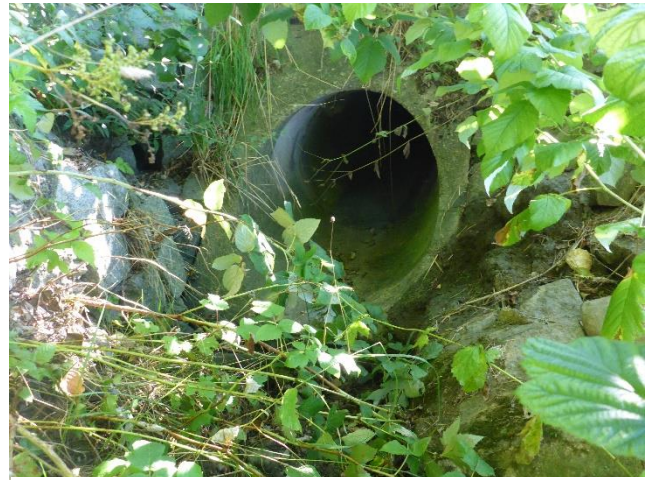
Abbildung 14 Durchlass am Birkenmoosgraben
